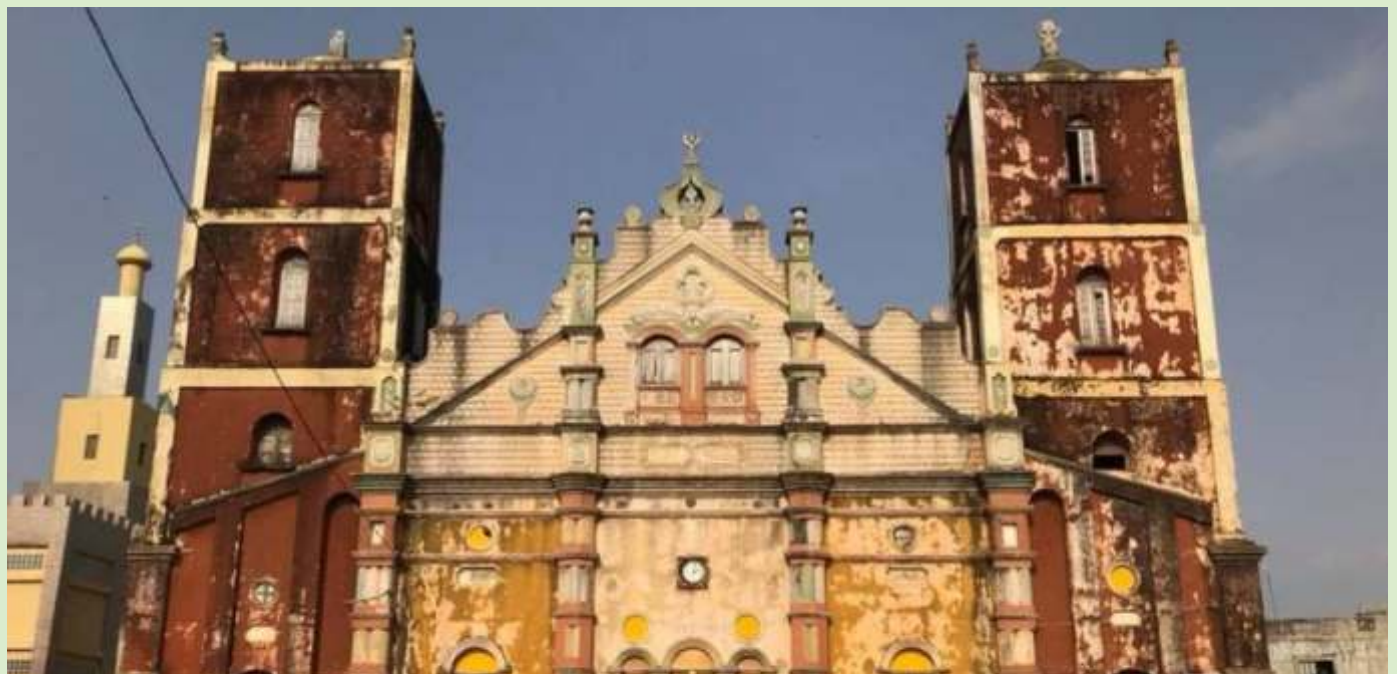
Mesquita com estilo arquitetônico das igrejas católicas brasileiras construídas por ex-escravos que voltaram ao Benim, no oeste da África
